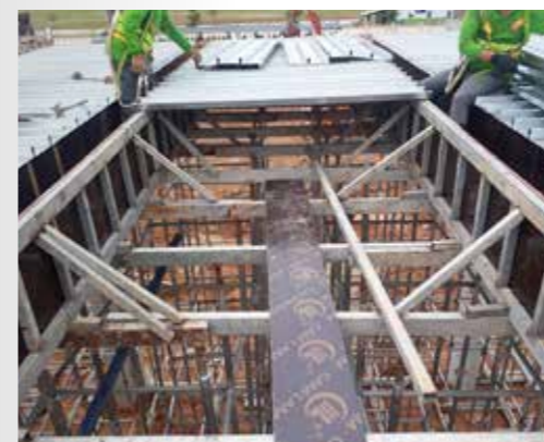
Bước 1: Lắp đặt các tấm sàn LYSAGHT® BONDEK®II vào hệ cốppha dầm bê tông và lắp đặt hệ chống nếu cần Step 1: Lay LYSAGHT® BONDEK®II sheets on concrete beam formwork and place props if required
