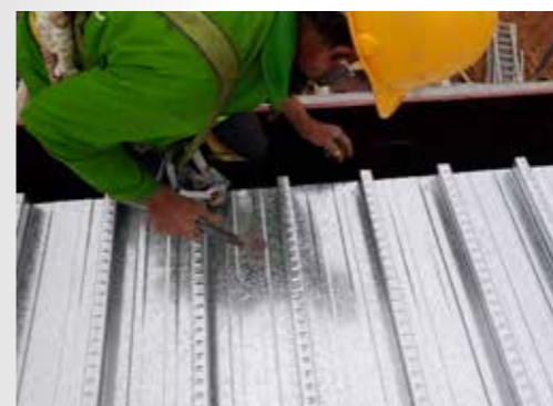
Bước 2: Liên kết tấm sàn LYSAGHT® BONDEK® II vào cốppha dầm bằng đinh thép và dán băng keo chống tràn bê tông Step 2: Fix LYSAGHT® BONDEK®II sheets to concrete beam formwork by nails/ screws and cover the end of LYSAGHT® BONDEK®II sheets by sealing tape
