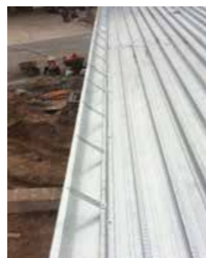
Bước 2: Liên kết tấm sàn LYSAGHT® BONDEK® II vào dầm thép bằng vít tự khoan và dán băng keo chống tràn bê tông và hệ diêm bao. Step 2: Fix LYSAGHT® BONDEK® II sheets to steel beams by self-drilling screw and cover the end of LYSAGHT® BONDEK®II lap by sealing tape
