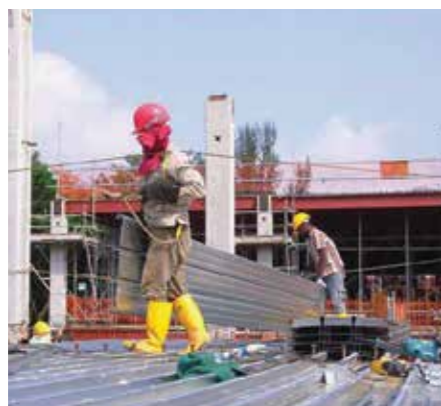
Bước 1: Lắp đặt các tấm sàn LYSAGHT® BONDEK®II vào hệ dầm thép và lắp đặt hệ chống nếu cần Step 1: Lay LYSAGHT® BONDEK®II sheets and place props if required
