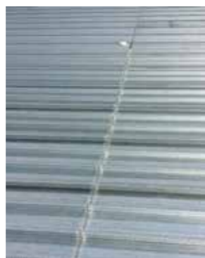
Bước 2: Liên kết tấm sàn LYSAGHT® BONDEK® II vào dầm thép bằng vít tự khoan và dán băng keo chống tràn bê tông và hệ diêm bao. Step 2: Fix LYSAGHT® BONDEK® II sheets to steel beams by self-drilling screw and cover the end of LYSAGHT® BONDEK®II lap by sealing tape
