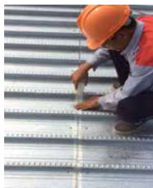
Bước 2: Liên kết tấm sàn LYSAGHT® BONDEK® II vào dầm thép bằng vít tự khoan và dán băng keo chống tràn bê tông và hệ diêm bao. Step 2: Fix LYSAGHT® BONDEK® II sheets to steel beams by self-drilling screw and cover the end of LYSAGHT® BONDEK®II lap by sealing tape
