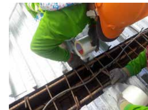
Bước 2: Liên kết tấm sàn LYSAGHT® BONDEK® II vào cốppha dầm bằng đinh thép và dán băng keo chống tràn bê tông Step 2: Fix LYSAGHT® BONDEK®II sheets to concrete beam formwork by nails/ screws and cover the end of LYSAGHT® BONDEK®II sheets by sealing tape
