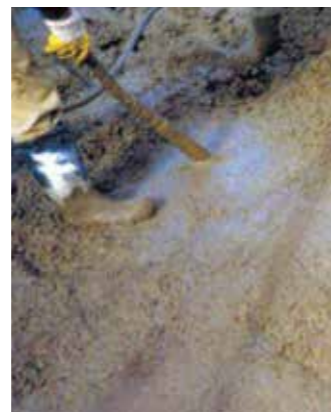
Bước 4: Tiến hành đổ bê tông sàn Step 4:
