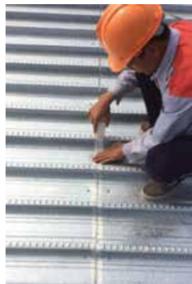
Bước 2: Liên kết tấm sàn Bondek II vào dầm thép bằng vít tự khoan và dán băng keo chống tràn bê tông và hệ điểm bao. Step 2:
