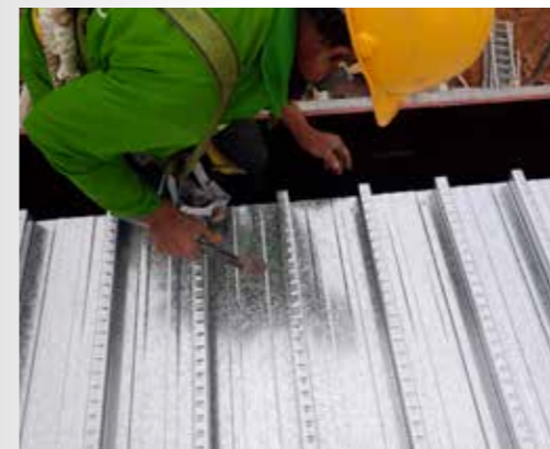
Bước 2: Liên kết tấm sàn Bondek II vào cốp pa dầm bằng đinh thép Step 2:
