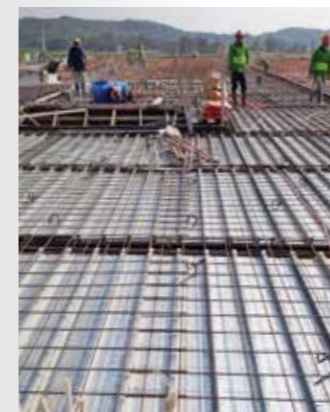
Bước 3: Lắp đặt lớp cốt thép dầm sàn và bố trí hệ MEP âm sàn (nếu có) Step 3:
