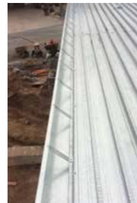
Bước 2: Liên kết tấm sàn Bondek II vào dầm thép bằng vít tự khoan và dán băng keo chống tràn bê tông và hệ điểm bao. Step 2:
