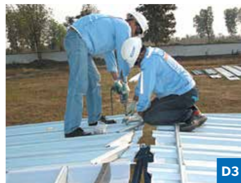
ติด PE Tape จากจุด A - จุด D
