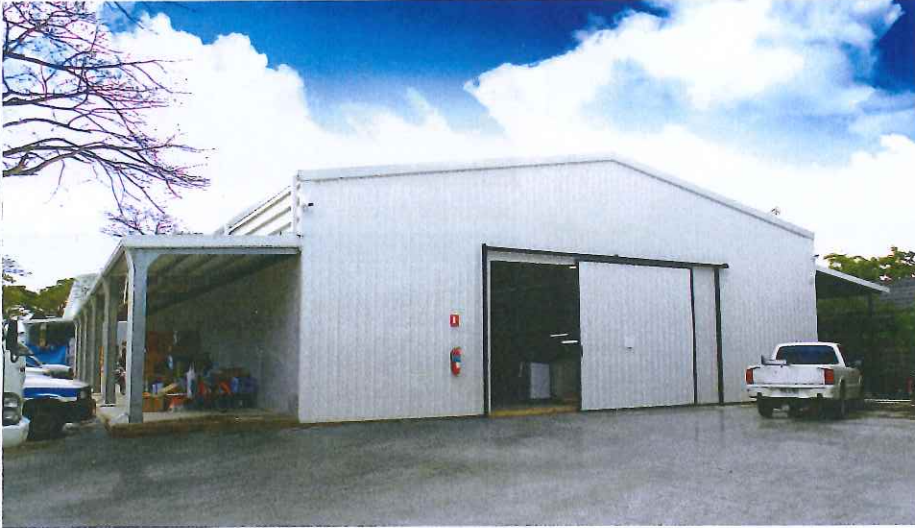
Thanawut Warehouse - Nakhon Si Thammarat
