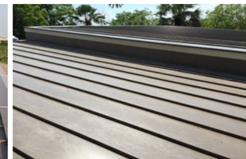
ติดตั้งแผ่นครอบ Ridge Capping และส่วนอื่นๆ จนครบ Install Ridge Capping Flashing and others until finish
