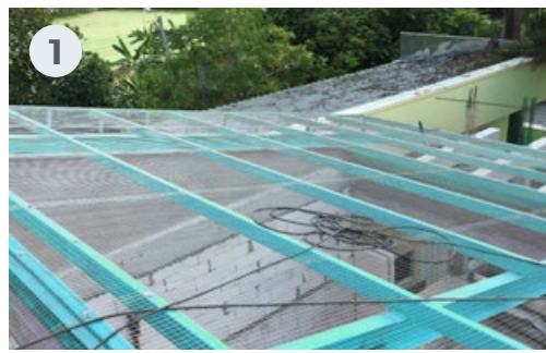
วางตาข่ายเหล็ก 1"x1" Place down steel wire 1"x1"
