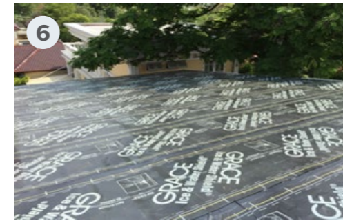
ปูแผ่น Bitumen จนเต็มพื้นที่ Place down bitumen sheet until fully cover the roof area
