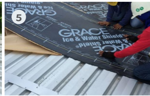
ปูแผ่น Bitumen ขวางแผ่นโดยมุงจากชาย แผ่นไปหาสันจั่ว Place down bitumen sheet by starting from eave to ridge
