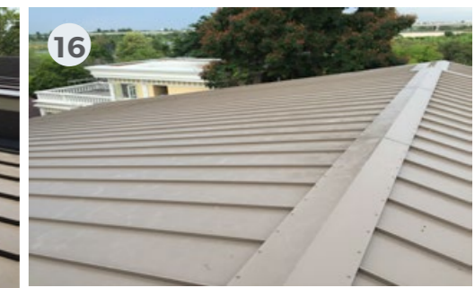
ยิงสกรู และ ยานิวซิลิโคน ตรงรอยต่อตาม มาตรฐาน Lysaght Screw and silicone at the roof joint by following Lysaght standard
