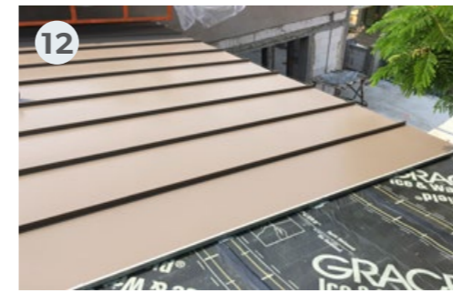
ติดตั้งต่อไปเรื่อยๆจนเสร็จ Continue the process until finish
