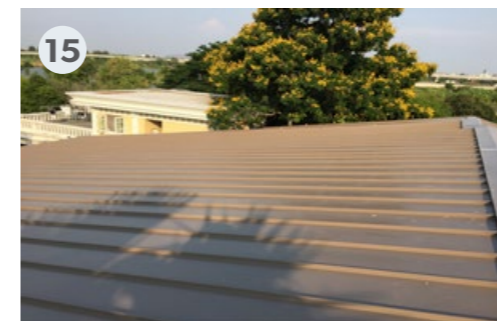
ติดตั้งแผ่นครอบ Ridge Capping และส่วนอื่นๆ จนครบ Install Ridge Capping Flashing and others until finish
