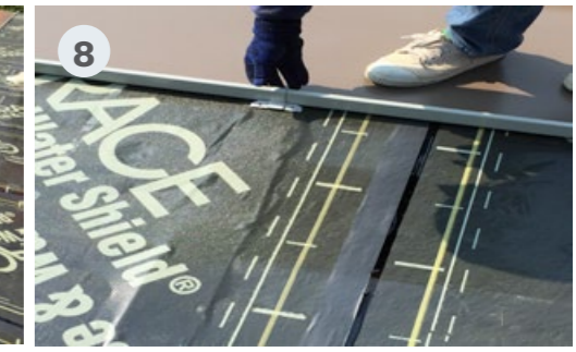
ตำแหน่งซากรูปที่ยิงสกรูยึดจะอยู่บริเวณ ของแนวแถบแผ่นเหล็ก Position of the clip is on the steel strip row
