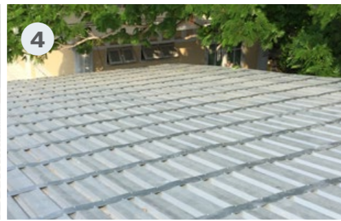
ยิงแถบแผ่นเหล็ก ทุกระยะ 0.60 ม. โดยใช้สกรู 10-16 x 16 WAF ยิงทแยง 2 ตัวต่อท้องลอน Install steel strip at 0.60 m. spacing, using 10-16 x 16 WAF screw, 2 screws per roof pan in oblique format
