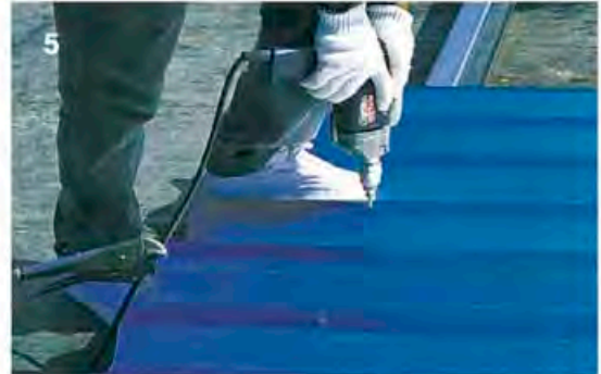
ขั้นตอนที่ 5 ทำการยึดสกรูบริเวณซ้อนทับที่สันลอนทุกช่วงแป
