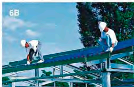
ขั้นตอนที่ 6A-6B หลังติดตั้งแผ่นหลังคาไปประมาณ 10 แผ่น ควรเช็คแนวระดับทุก ๆ ระยะ
