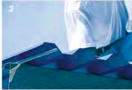
ขั้นตอนที่ 2 เช็คลายแผ่นของหลังคาให้ยื่นล้ำไปในแนวรางน้ำอย่างเหมาะสม
