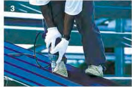
ขั้นตอนที่ 3 ยึดสกรูทุก ๆ สันลอนบริเวณแปปลาย และแปเดี่ยว ส่วนแปกกลางให้ยึดลอนเว้นลอน
