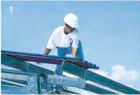
ขั้นตอนที่ 1 ติดตั้งแผ่นหลังคาแผ่นแรกโดยให้ลอนตัวเมียอยู่ติดหน้าจั่ว
